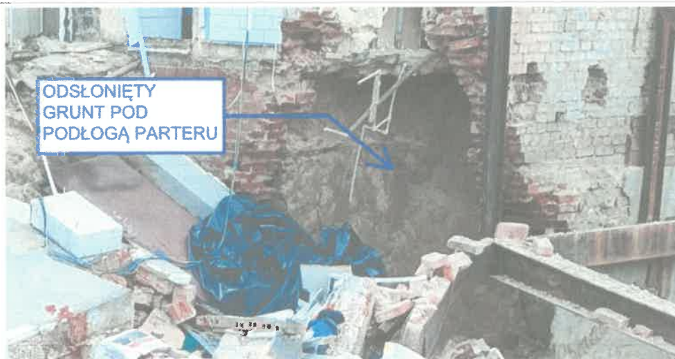
Ryc. 06. Odsłonięty grunt pod podłogą parteru.
