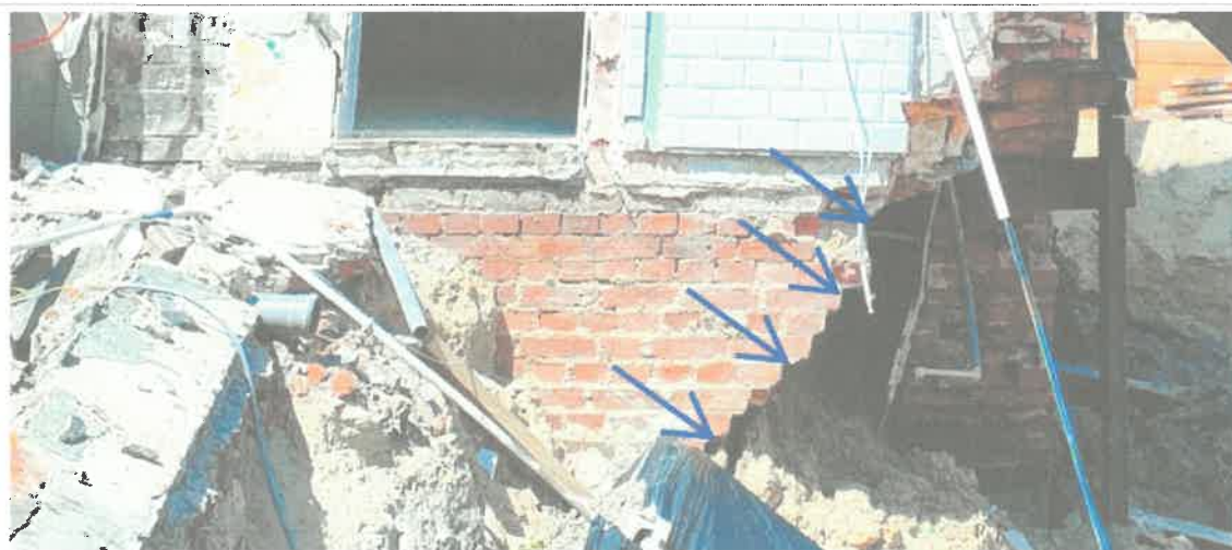
Ryc. 03. Widok ściany fundamentowej w osi „3” od strony zniszczonej przybudówki.
