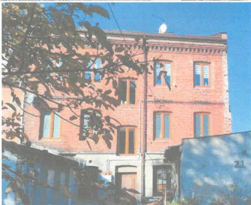
Fot. 04. Elewacja od strony ul. Warszawskiej – widok ogólny przed katastrofą.
